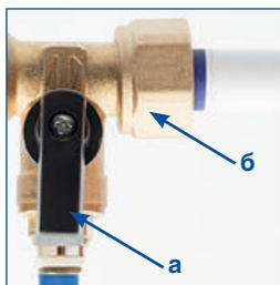
15. Откройте кран (а) на узле подключения (б). Отрегулируйте напор воды
