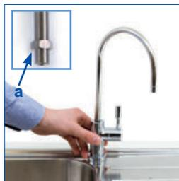
7. Вставьте хвостик крана в отверстие. Наденьте на него пластиковую шайбу, металлическую шайбу и закрепите крепежной гайкой (а)
